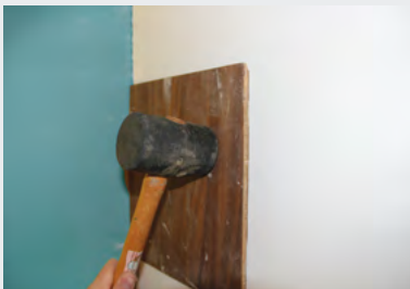
Licht aanduwen met behulp van een plank en een rubberen hamer
